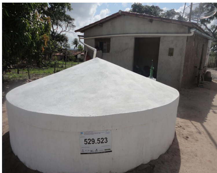
Figura 4 - Cisterna de placas.
