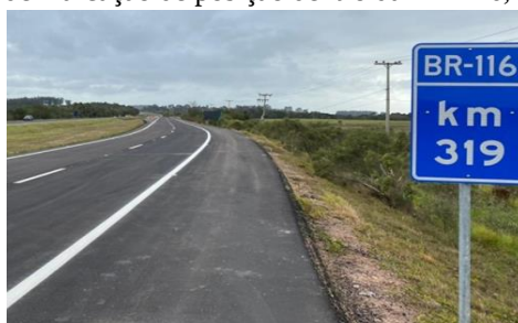
Figura 8: Placa de marcação de posição dentro da BR-116, posição km 319.
