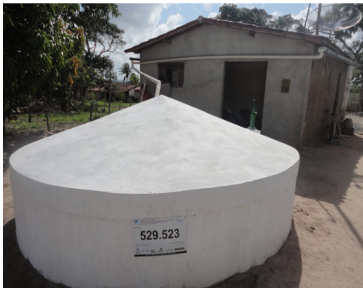
Figura 4 - Cisterna de placas.
