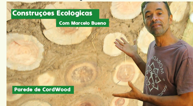
Parede de CordWood
